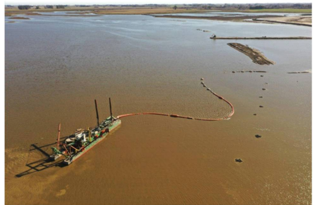
Draga Victoria 3 y su cañería flotante.
